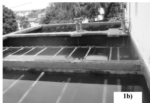
**Figuras 1a e 1b. Vista do ponto de aplicação (PA) do sulfato de alumínio dentro da calha Parshall (1a) e do sistema de filtragem (1b) na ETA do SAAE – Itapetinga.**
